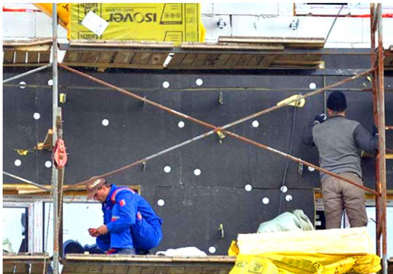
Вентилируемые системы для фасадов оснащаются специальными плитами из минеральной ваты. Плиты изготавливаются на основе стекловолокна или базальта. Эти материалы отличаются устойчивостью к температурным перепадам, теплопроводностью, пожаробезопасностью, хорошей паропроницаемостью, жесткостью, сопротивляемостью к выветриванию, биостойкостью.
