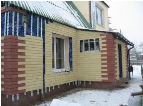
Облицовка вентилируемого фасада является навесной защитой утеплителя и несущих конструкций, устойчивой к внешним воздействиям. При повреждении быстро ремонтируется и легко чистится от загрязнений. Способствует созданию индивидуального облика здания за счет разнообразия используемых материалов, цветовой гаммы, форм и структур, схем прохождения швов.
