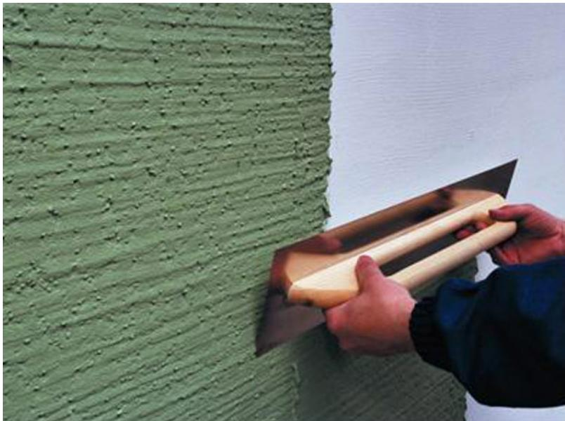
Необходимо сделать тщательную грунтовку фасада перед тем, как его декоративно покрывать. Грунтовка может быть белого цвета или колерованной. В отличие от обычной грунтовки колерованная грунтовка стоит немного дороже. Но, ее основное преимущество состоит в том, что в процессе эксплуатации при сколах мокрого фасада вы сможете увидеть армирующий слой, который прокрашен таким же цветом как декоративное покрытие. Такой скол на фасаде почти не заметен. После грунтовки наносится декоративный слой.
